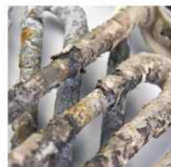
Fot. 70. Kamień kotłowy na grzałce pralki.
