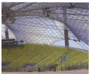
Fot. 91. Sklepienie Stadionu Olimpijskiego w Monachium wykonano w całości z PMMA.
