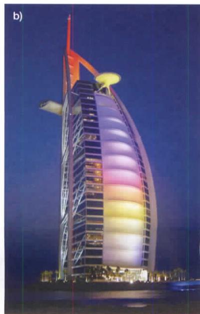
Fot. 47. Elewacja hotelu Burj Al Arab w Dubaju została wykonana z włókna szklanego pokrytego teflonem: a) w ciągu dnia teflonowa powłoka chroni wnętrze budynku przed promieniowaniem słonecznym, b) w nocy powłoka służy jako ekran projekcyjny barwnego pokazu światel.
