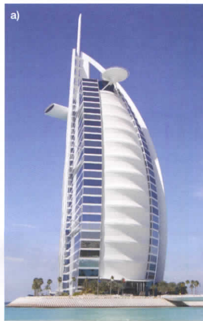
Fot. 47. Elewacja hotelu Burj Al Arab w Dubaju została wykonana z włókna szklanego pokrytego teflonem: a) w ciągu dnia teflonowa powłoka chroni wnętrze budynku przed promieniowaniem słonecznym, b) w nocy powłoka służy jako ekran projekcyjny barwnego pokazu światel.
