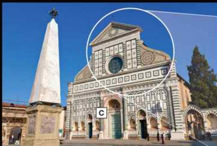
Elewacja kościoła Santa Maria Novella we Florencji została zaprojektowana w nowatorski sposób. Jej szczyt zdobi trójkątny tympanon A , a po bokach zamykają ją ozdobne podwójne woluty, czyli ślimacznice B . Tego typu rozwiązanie zapożyczyło wielu późniejszych budowniczych. Front świątyni zdobią również cztery kolumny korynckie C .
