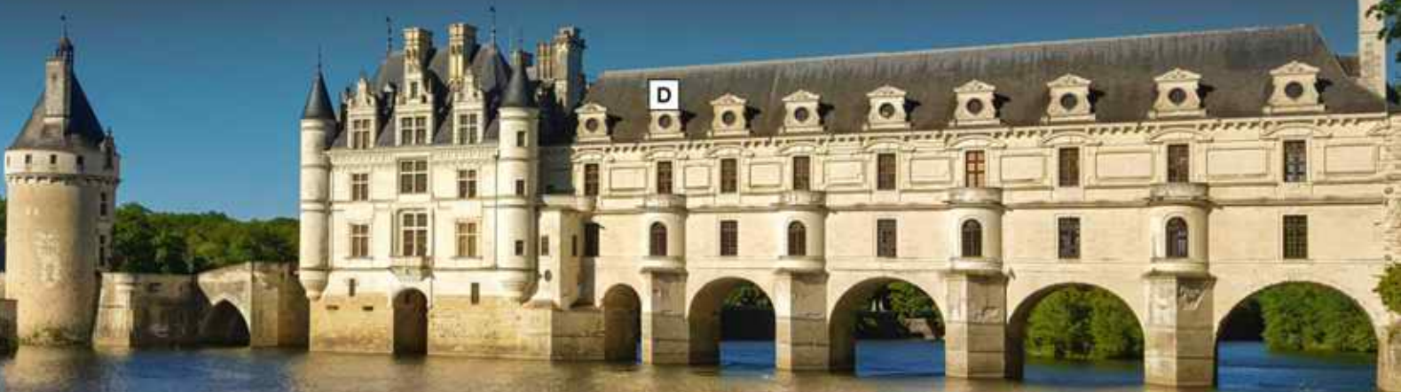
Zamek Chenonceau [czyt.: szenoso] to wyjątkowa budowla – stanowi zarówno luksusową rezydencję, jak i most nad rzeką Char [czyt.: szar]. Został zbudowany z zastosowaniem rozwiązań charakterystycznych dla francuskiego renesansu, m.in. znajdujących się na poziomie dachu okien mansardowych D .
