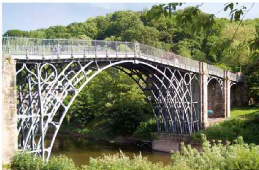
Most żelazny wzniesiony z inicjatywy Johna Wilkinsona w 1779 r. do dziś łączy oba brzegi rzeki Severn w zachodniej Anglii. Konstrukcję wykonano, wzorując się na rozwiązaniach stosowanych w budowliach drewnianych.
