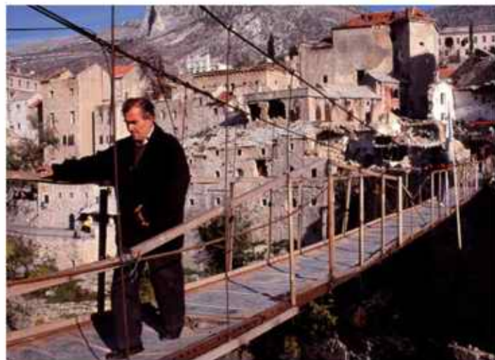
Tymczasowy most nad rzeką Neretwą w Mostarze w Bośni zawieszono w miejsce zabytkowego Starego Mostu, który został zburzony przez siły chorwackie podczas wojny w Bośni w 1993 r. Ten niezwykle cenny zabytkowy obiekt z listy UNESCO został odbudowany w 2004 r.
