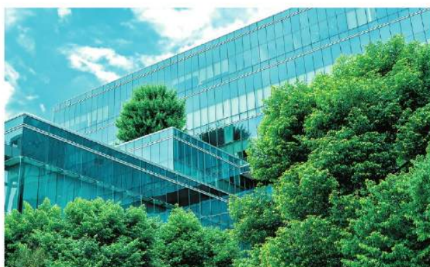
Troska o roślinność wokół budynków biurowych; drzewa i ogrody na dachach to działania ekologiczne firm
